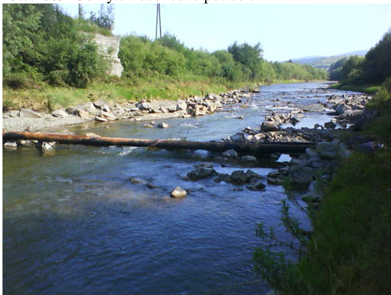
15.7.2009 Odkryté vodovodné potrubie.
