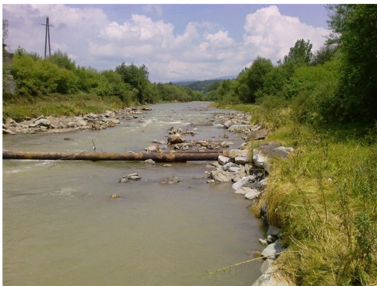
15.7.2009 Odkryté vodovodné potrubie.
