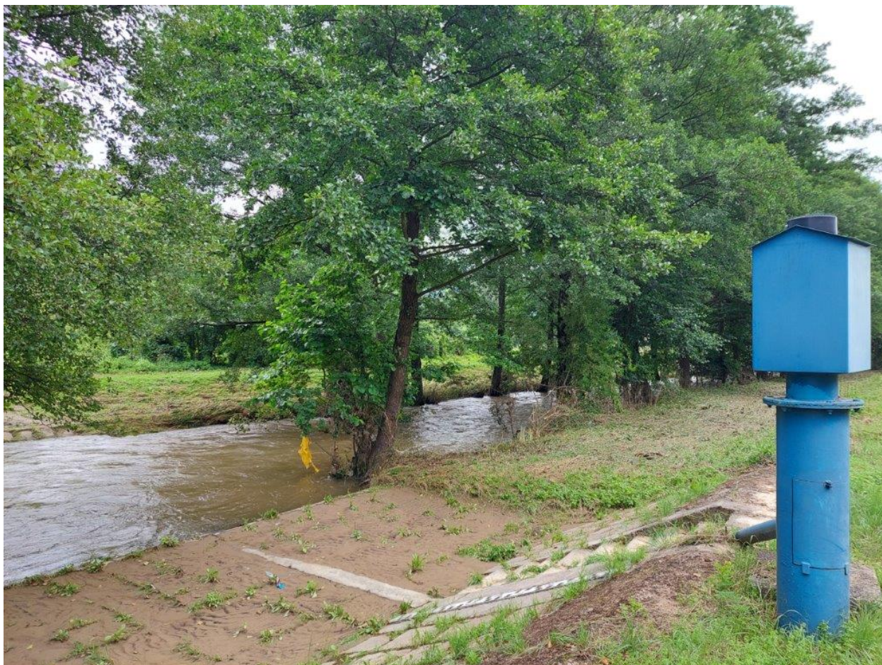
Obrázok 3. Stopy po povodni vo vodomernej stanici Plešivec na Štítniku (foto K. Slivková).
