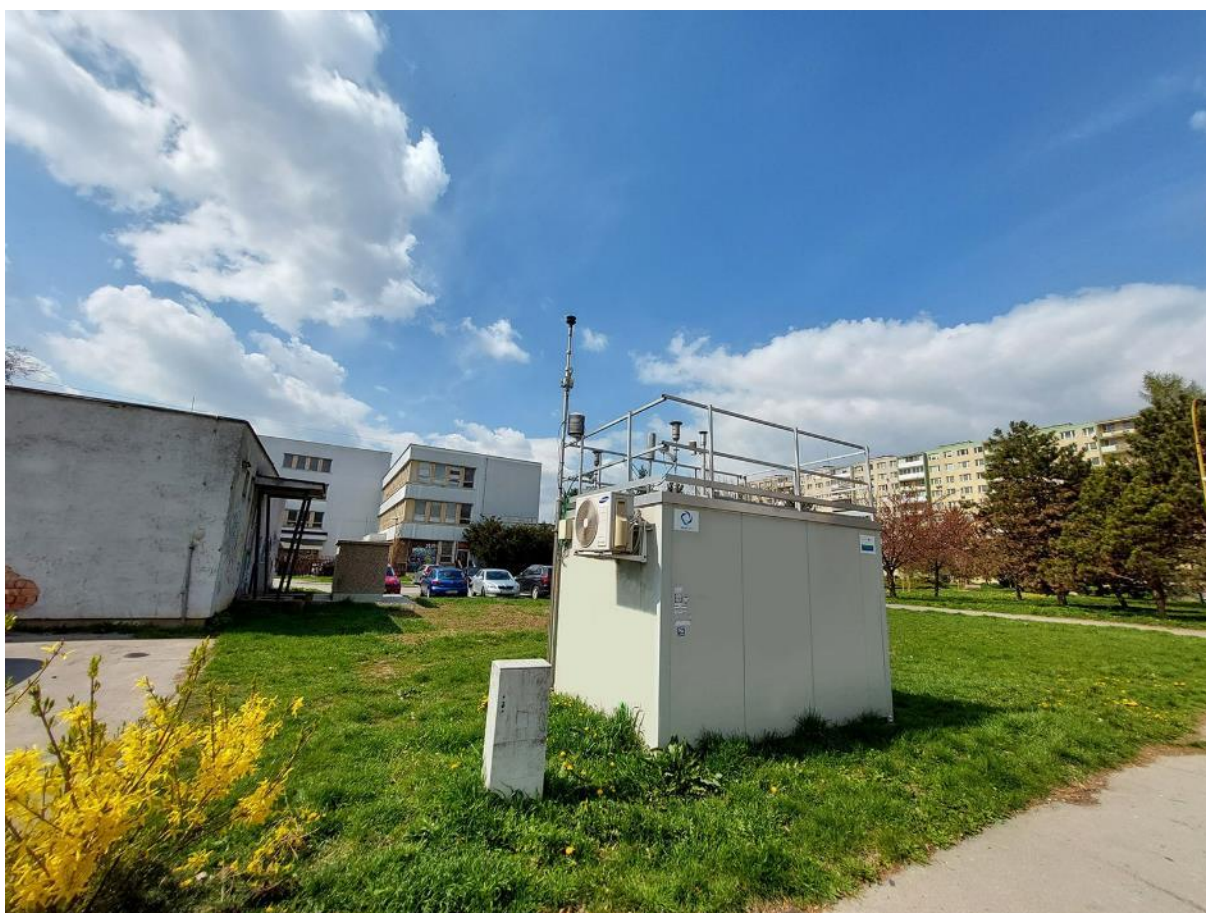
Pohľad na stanicu
