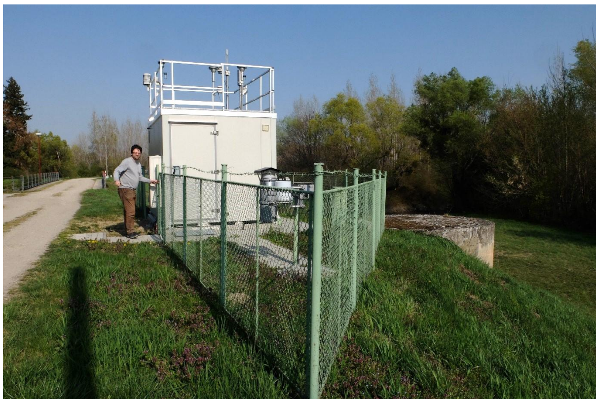
Pohľad na stanicu
