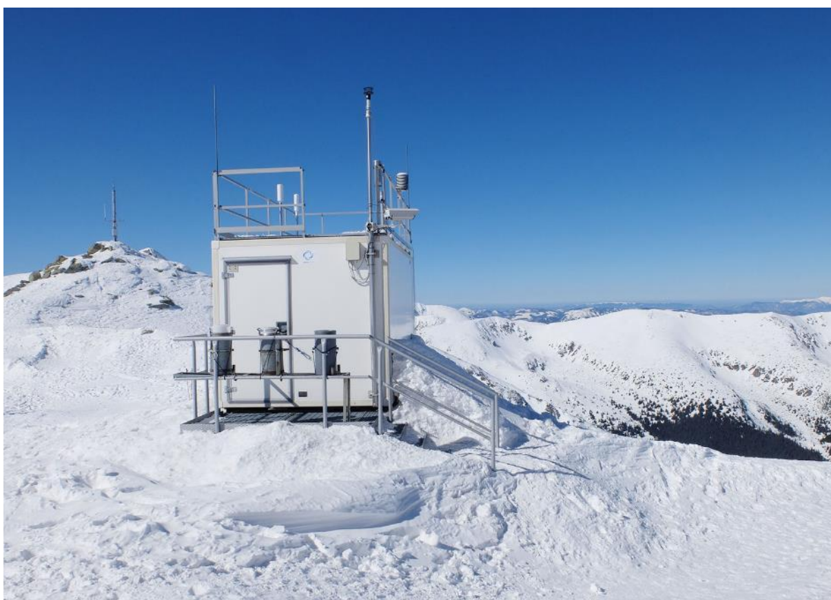
Pohľad na stanicu
