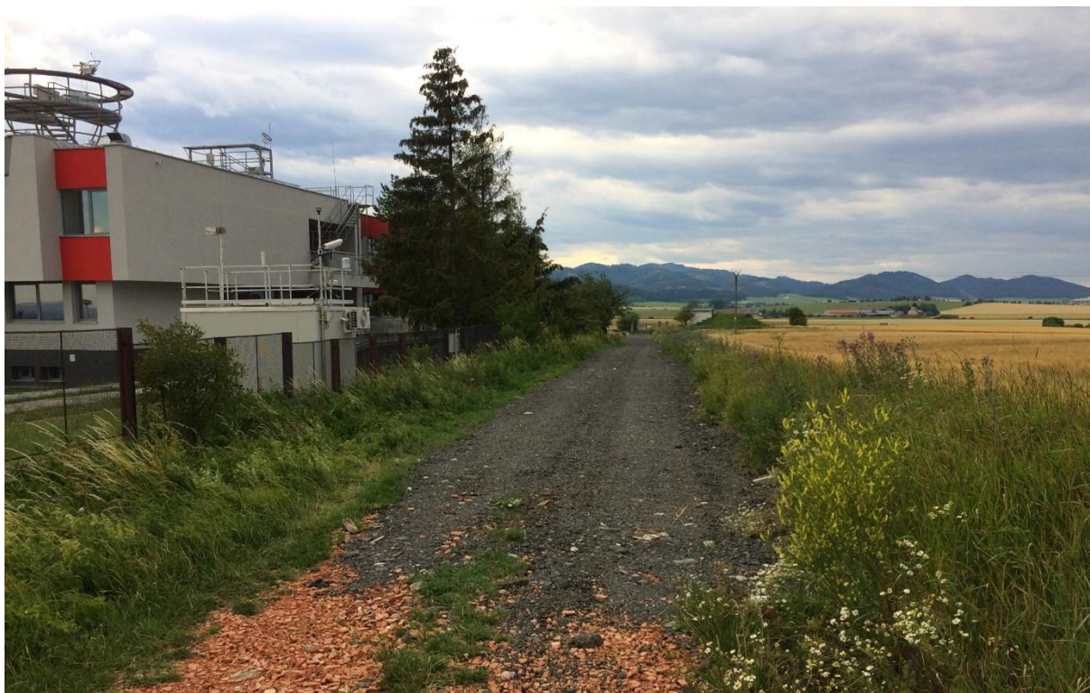
Pohľad na stanicu
