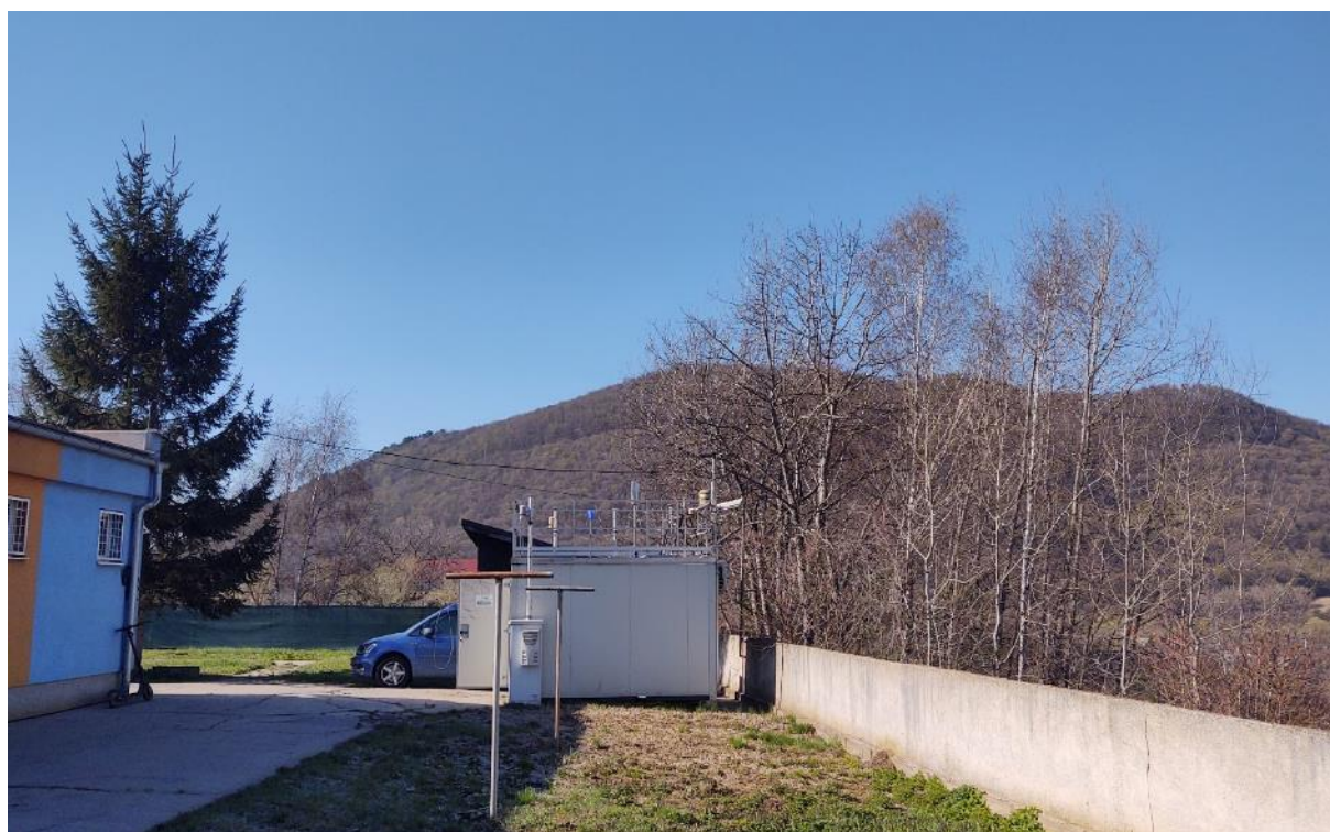
Pohľad na stanicu
