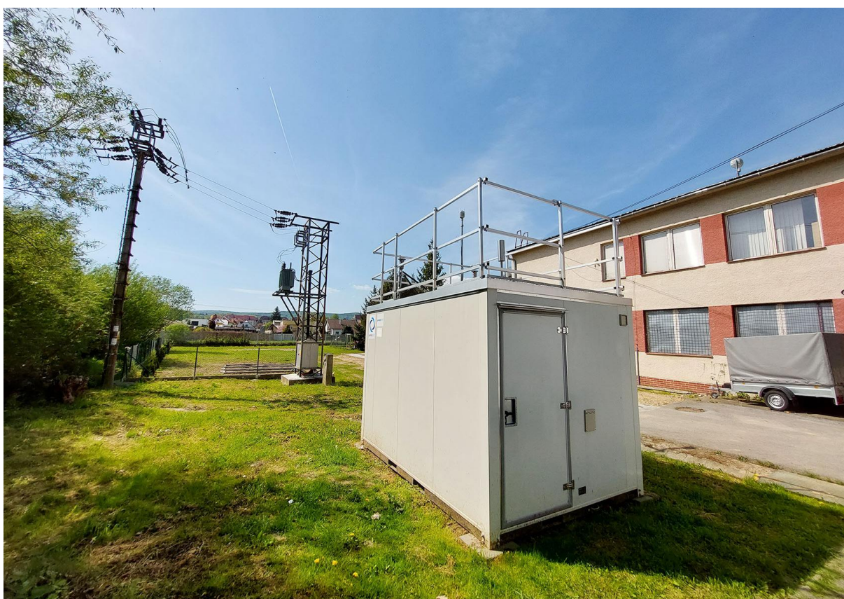
Pohľad na stanicu
