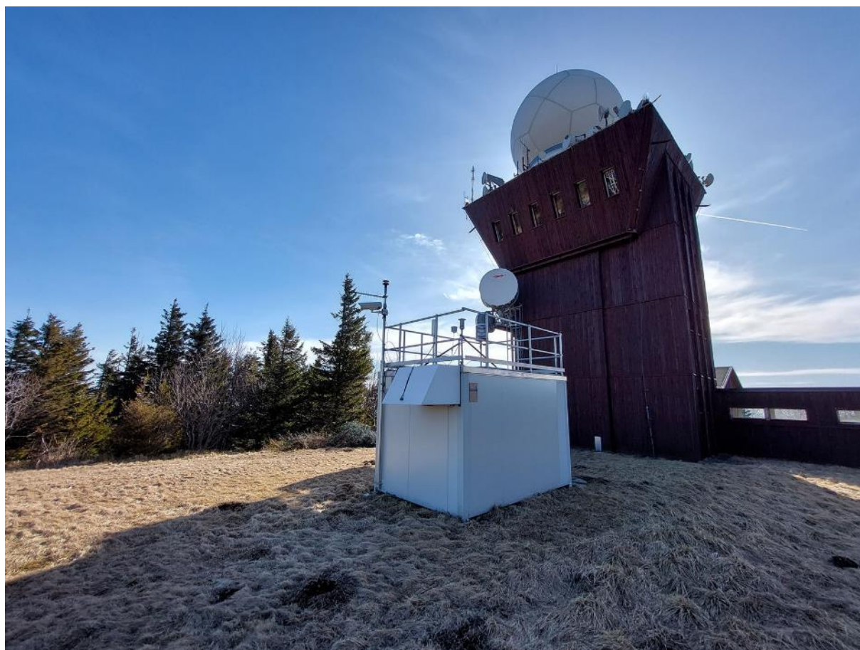
Pohľad na stanicu
