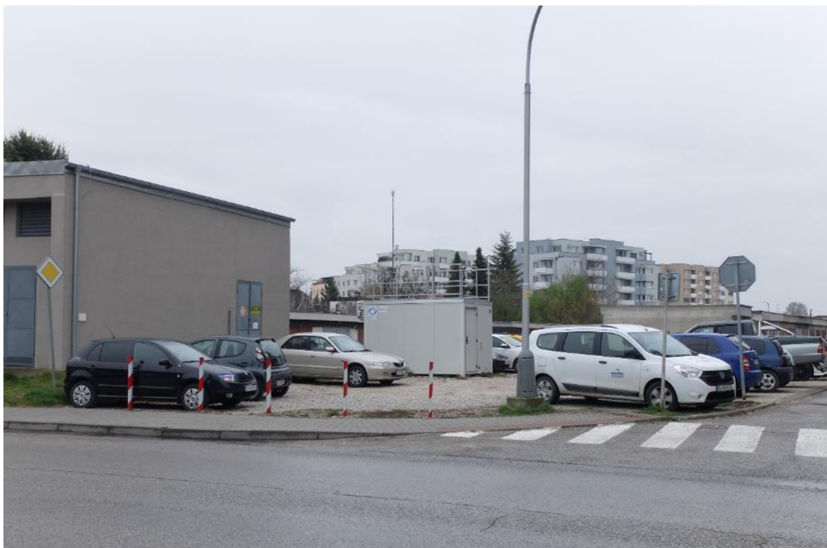
Pohľad na stanicu
