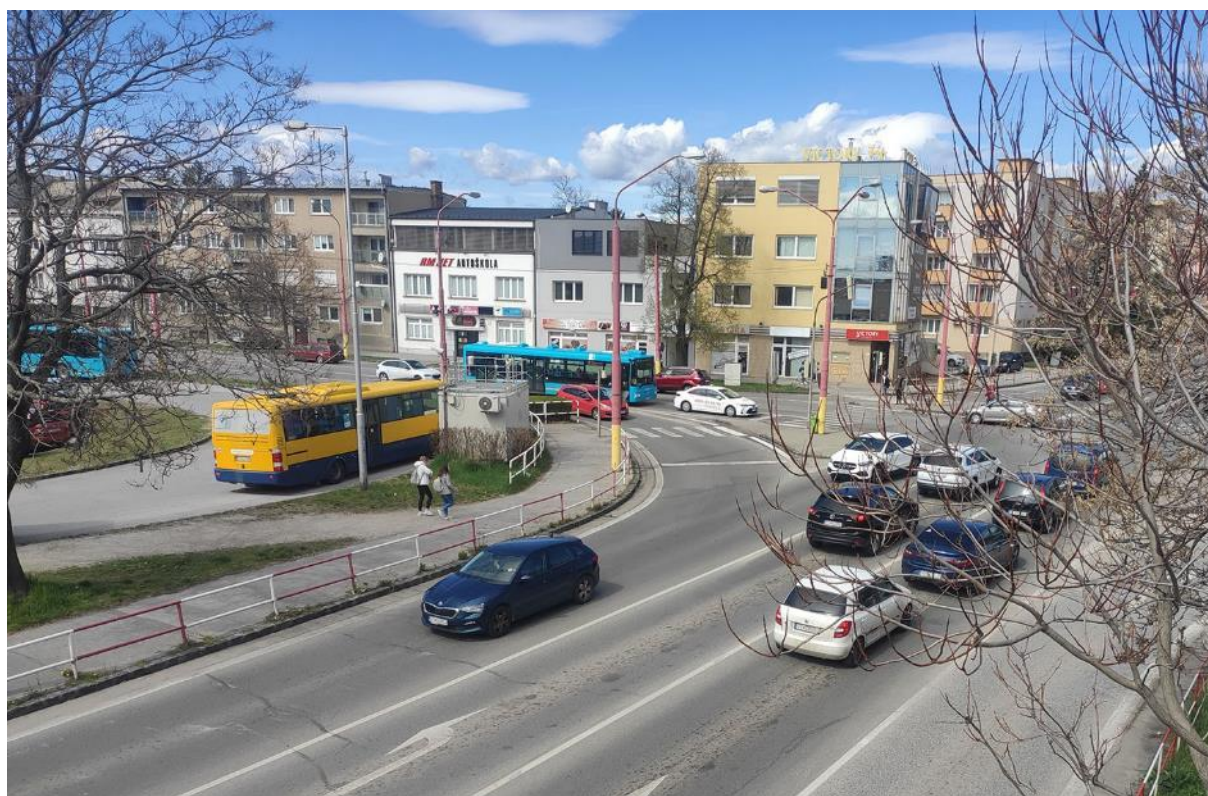
Pohľad na stanicu
