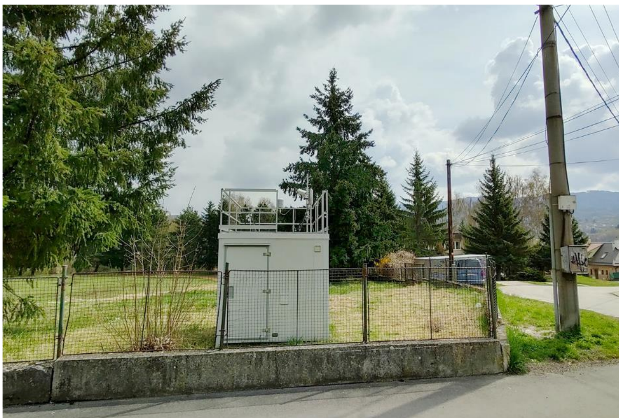
Pohľad na stanicu
