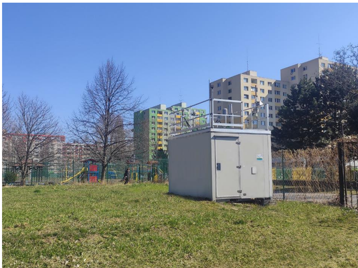
Pohľad na stanicu
