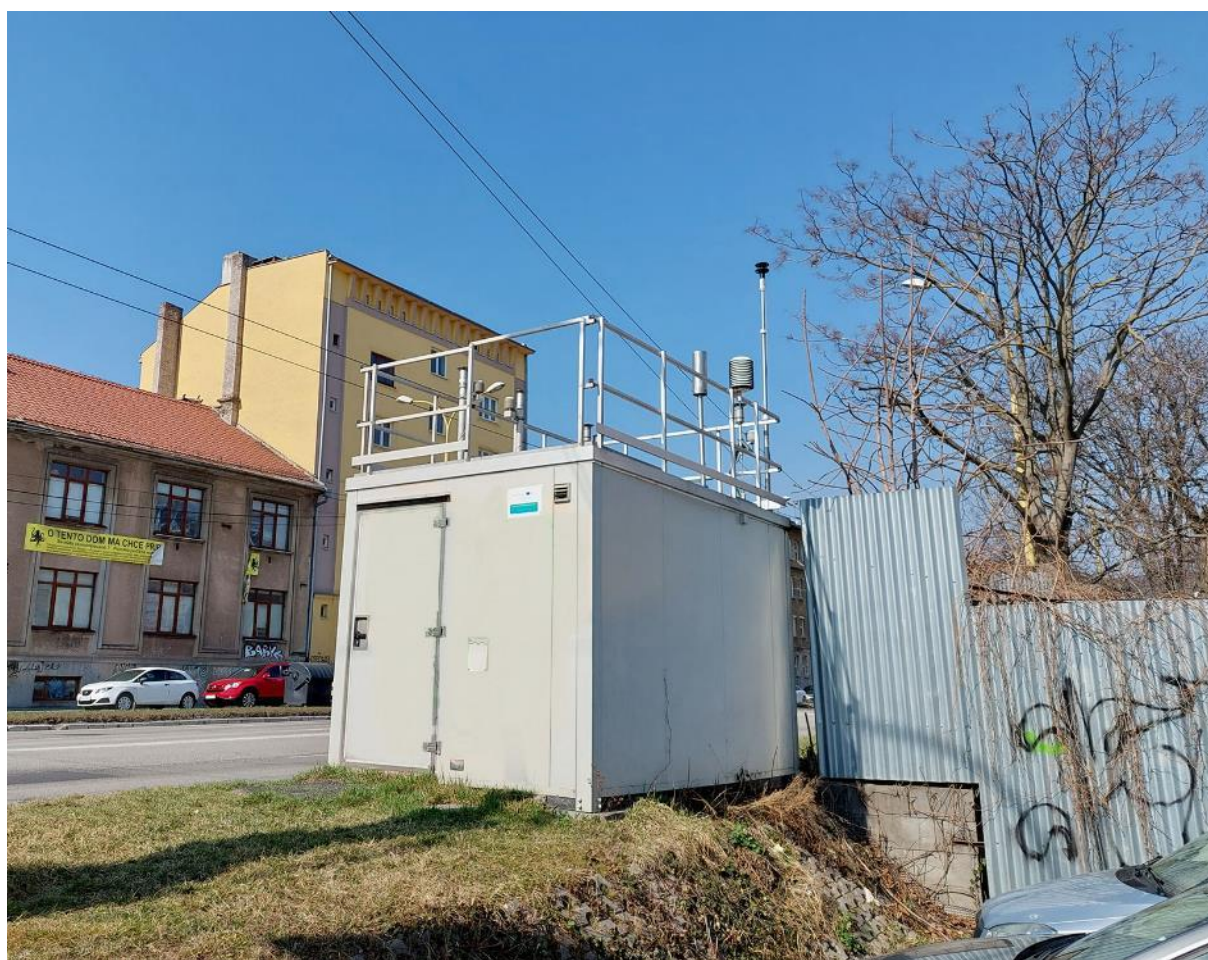
Pohľad na stanicu
